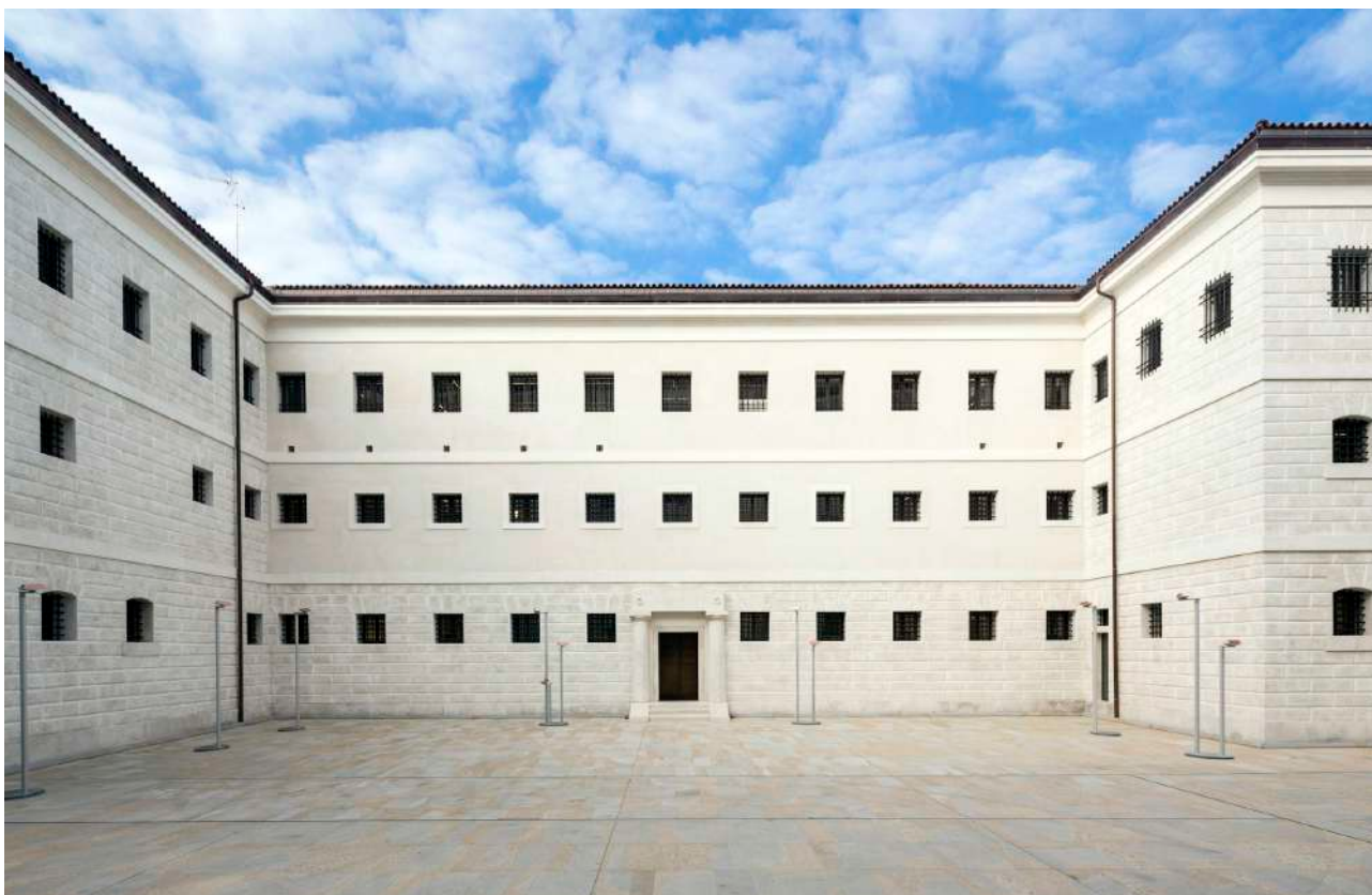
A destra: Viste del corridoio del primo piano. In questa pagina: Vista delle Gallerie delle Prigioni dal cortile interno del Palazzo dell'ex Tribunale.
