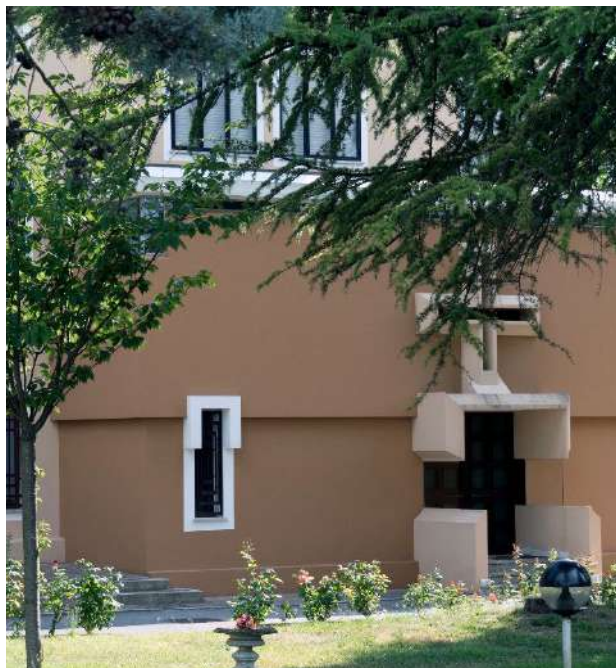
La sede delle Suore di Carità di San Vincenzo de Paoli lungo la Restera di Treviso.
